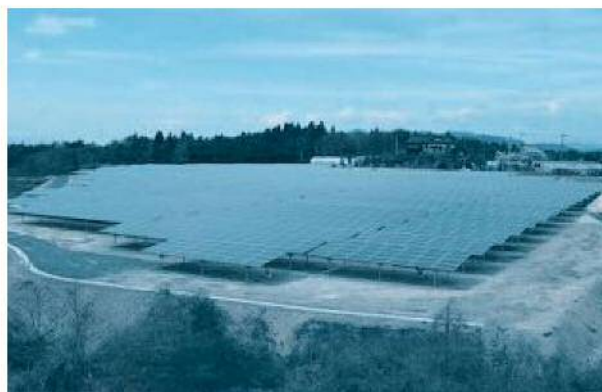
(株)平成電設のメガソーラー(滝沢地内) 太陽光パネル最大出力 1,202kW
