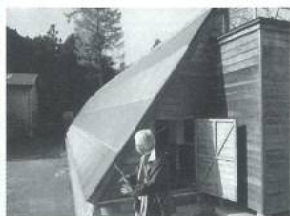
温風が出来る外側南壁面
