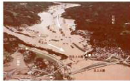
国土交通省岩手河川国道事務所北上川上流水害写真集より（直後から砂鉄川の大改修工事が始まり、完工しています）
