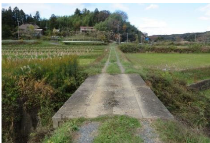
川ノ口 2 号橋(供用 53 年)
