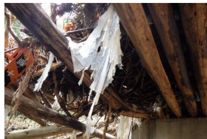
木桁の腐朽
