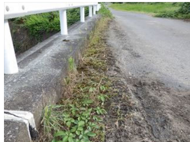
写真-3.6 土砂堆積
