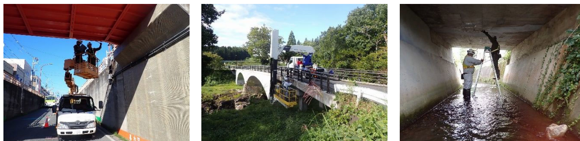
写真-3.1 定期点検状況
