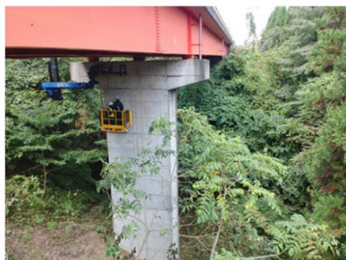
ゴンドラ車による点検
