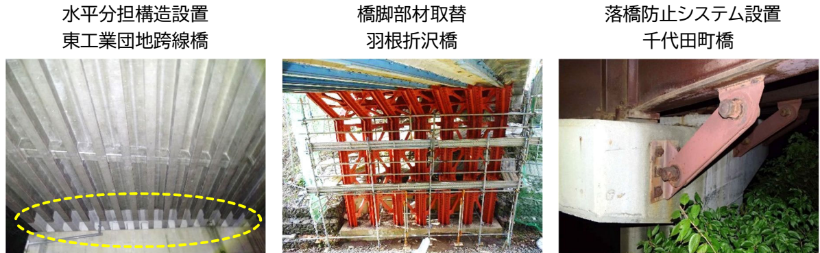
写真-3.8 耐震補強対策事例
